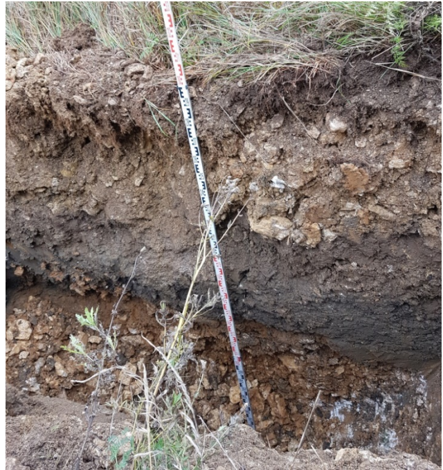
Bild 8: Schurfgrube SCH H
